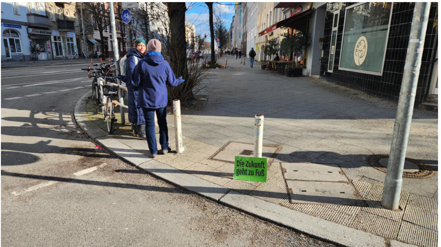
Kolonnenstraße Ecke Naumannstraße • Ampel mit taktiler Aufstellfläche, allerdings mit behindernden Gehwegpollern
